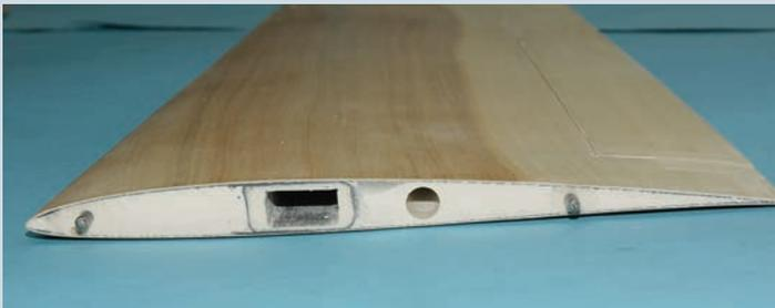
Die beiden Flächenbolzen in der Wurzelrippe müssen noch verklebt werden
